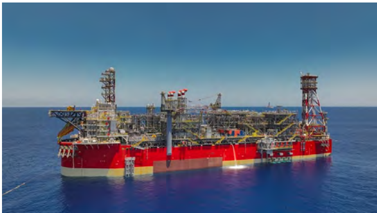
איור 2: אסדת 'כריש' הממוקמת באזור הכלכלי הבלעדי של ישראל מדרום לגבול הימי עם לבנון 8
