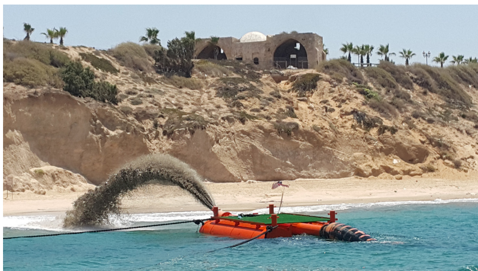
איור 5: הזנת חול סמוך לקו המים, לאורך המצוק בחוף "ברנע" (צפון אשקלון) (21.7.2015)
