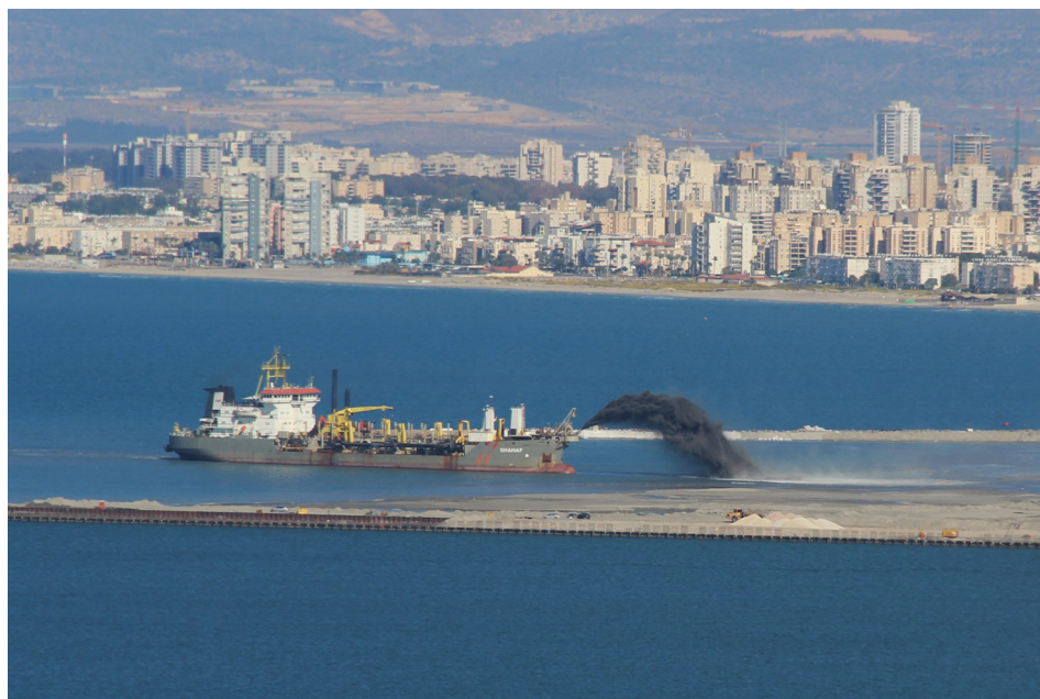
איור 3: ייבוש בחול של שטח מסוף המכולות בנמל "המפרץ", על ידי אוניית המחפר "שחף" (צולם על ידי עמרי בן אליהו, 16.11.2017)
