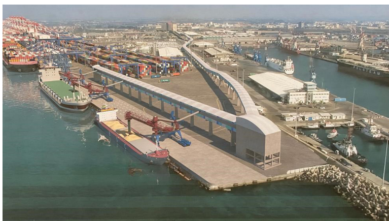
איור 5: אילוסטרציה לרציף מתמחה עם מסוע גרעינים למגורות אשדוד שיעבוד בהספק פריקה של עד 1,500 טון לשעה. סיום הפרויקטים מתוכנן לסוף שנת 2022.
