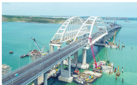
איור 6: גשר קרים בבנייתו
