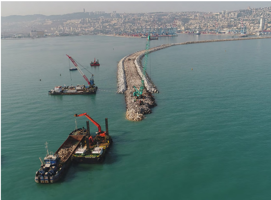
איור 3. הארכת שובר גלים נמל חיפה
