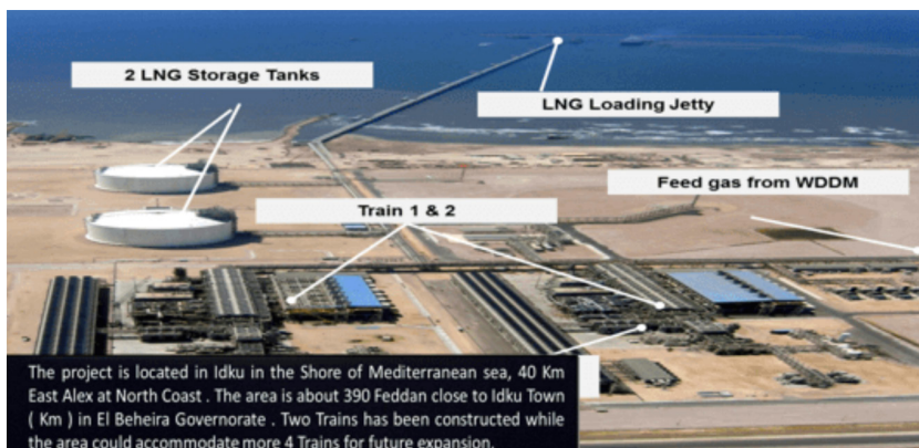
איור 7: מתקן ההנזלה Idku עם כושר ייצור של כ־7.2 מיליון טונות גז נוזלי בשנה ופוטנציאל לגידול נוסף 36
