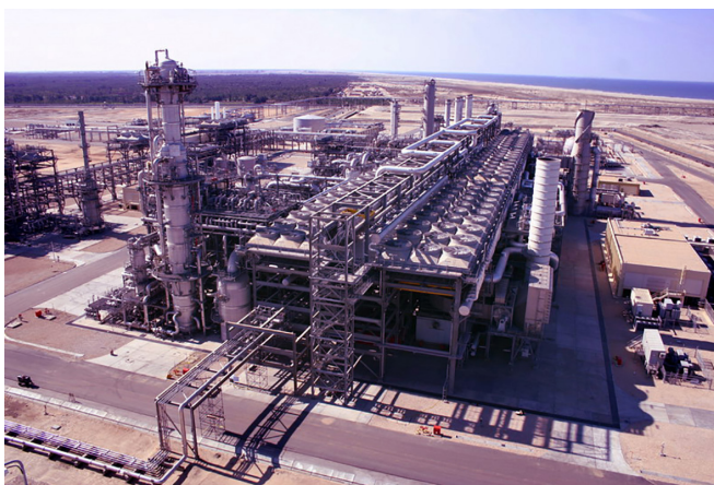
איור 8: מתקן ההנזלה ב־Damietta שחידש פעילותו, והוא עם כושר ייצור של כ־5 טונות גז נוזלי בשנה עם פוטנציאל גידול ככל שיורחב 37
