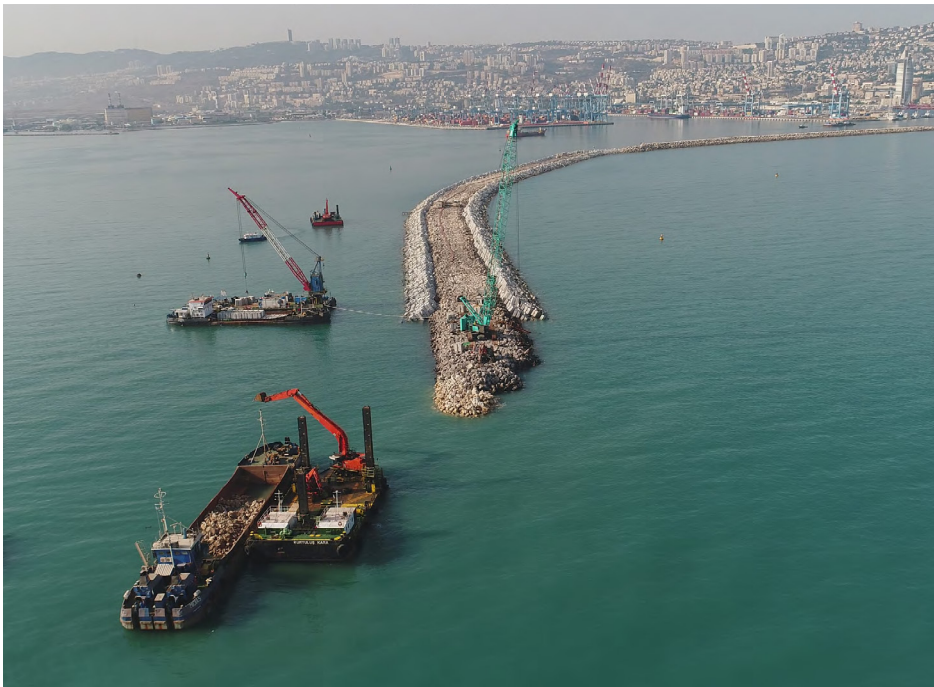
איור 3. הארכת שובר גלים נמל חיפה
