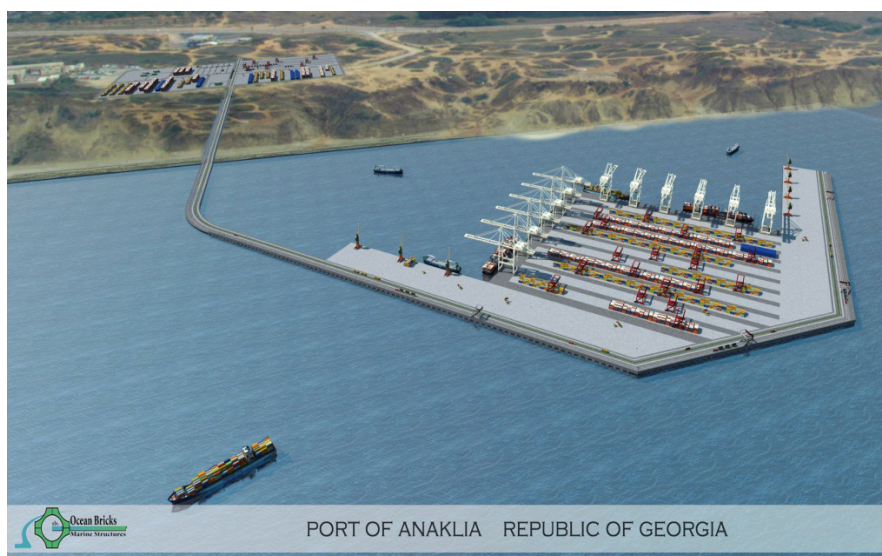
איור 4: מודל של אי מלאכותי עבור נמל שהוכן למען נמל בגאורגיה בטכנולוגיית OBS
